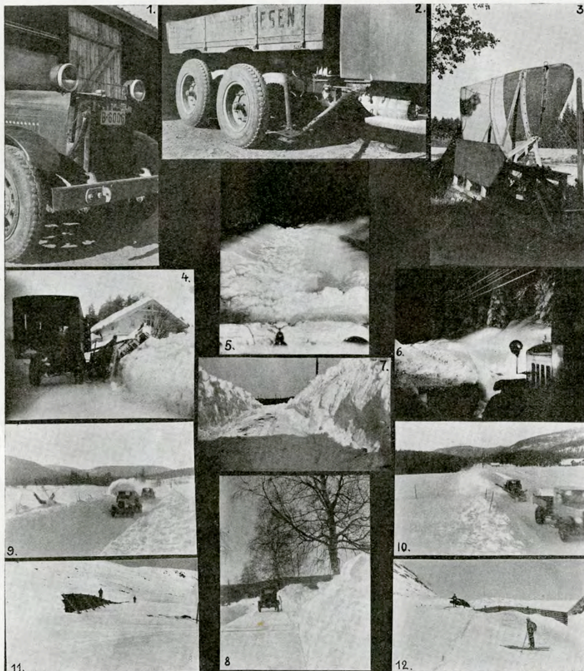
Fig. 1. Vinkeljernsramme for befestigelse av Øveråsens forploger. — Fig. 2. Sideplogens festeanordning til bilen. — Fig. 3. Forsterkning av øverste parti av sidevoenen. — Fig. 4. Ved Svarstad i Lågendalen februar 1931. — Fig. 5 og 6. Brøtning på Meheia ved natt. 25/1 1931. — Fig. 7. Rutebilbrøtning Tønsberg—Vivestad mars 1931. — Fig. 8. Ø. hovedvei ved Rymoen i Brandvald 16. mars 1931. Snekantens høide ved bilen 1,5 m. — Fig. 9. Riksveien Hakadal gr. Brandbu st. Utvidelse av veien med forplog og sideplog. Fart 30–85 km. Fig. 10. Samme vei. Sneen kastes 5 m. til siden. Snekantene uvesentlig høiere enn snedybden forøvrig. — Fig. 11. Geirangerveien i Øpland 19. april 1931. Sneskjerm opsatt 1930. Virket bra. — Fig. 12. Skjåkjellveien i Øpland 20. juni 1931. Skjermen har virket bra, men der bør oppsettes en ledeskjerm på veiens utside.
